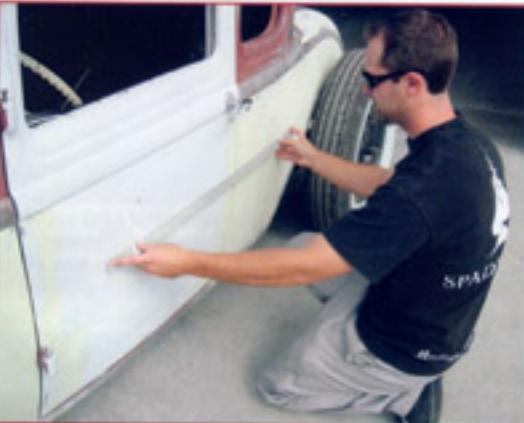
Shaun Spade kollar in vårt slipjobb för att vara säker på övergången mellan dörr och sidopanel är så raka som möjligt. En lång linjal är ett bra verktyg att använda för att kolla panelerna.
